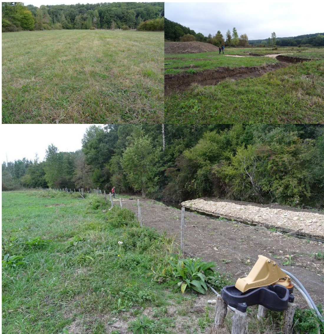
Prairie restaurée (en haut à gauche), bras secondaire recreusé (en haut à droite) et la Boivre mise en défens (en bas)
